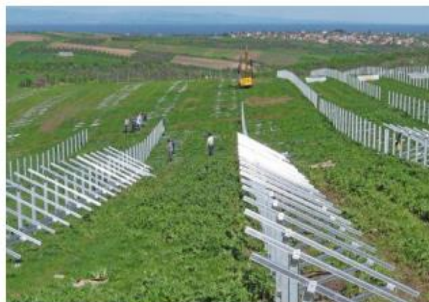
Slika 2.3-1 Detalj montaže podkonstrukcije bez temeljenja (izvor: Idejno rješenje - elektrotehnički projekt, Neintegriрана sunčana elektrana, Ivanec, ožujak 2022.).
