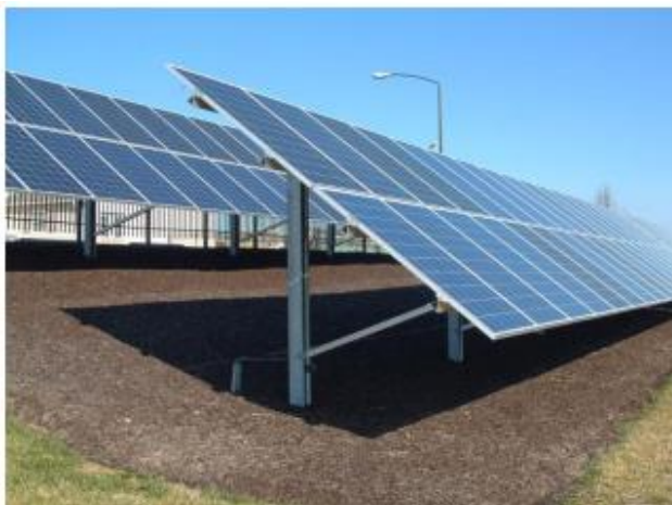
Slika 2.3-1 Detalj montaže podkonstrukcije bez temeljenja (izvor: Idejno rješenje - elektrotehnički projekt, Neintegriрана sunčana elektrana, Ivanec, ožujak 2022.).
